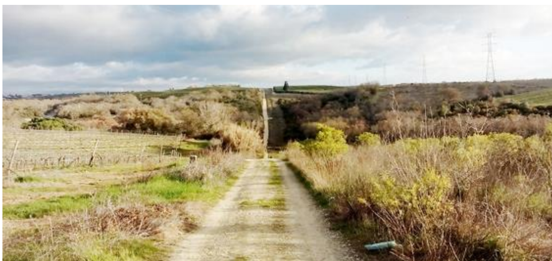
Figura 12 – Via proporcionada pela conduta subterrânea proveniente de Castelo de Bode para Lisboa, em Santarém
