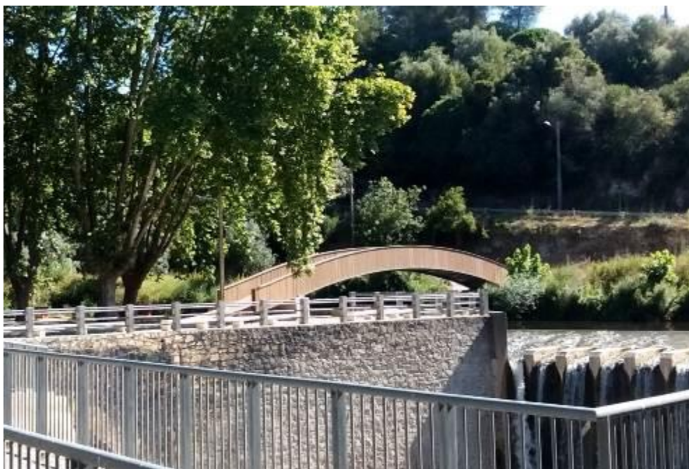
Figura 21 – Ponte sobre o rio Alviela em Pernes
